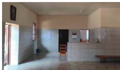
Remont przychodni w Gatara (Burundi)
