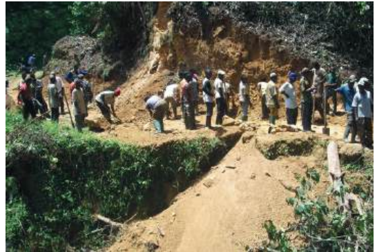
Budowa mostu w Ebase-Bajoh (Kamerun)
