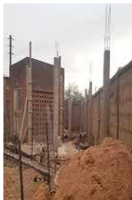
Budowa studni głębinowej w Gayaza (Uganda)
