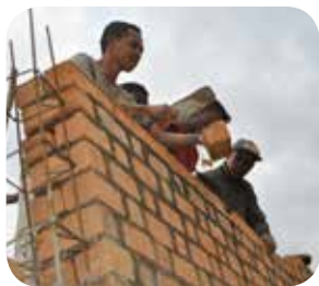
Budowa stróżówki w Mampikony, Madagaskar
