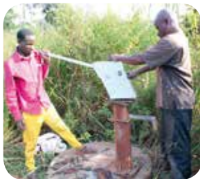
Konserwacja 9 studni w Bukoba, Tanzania
