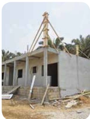
Budowa porodówki w Ayos, Kamerun
