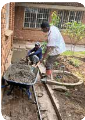
Odnowienie budynków szkoleniowych w Bukavu, DRK
