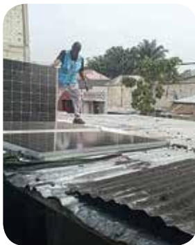
Odbudowa instalacji fotowoltaicznej w przychodni w Kinszasie, DRK
